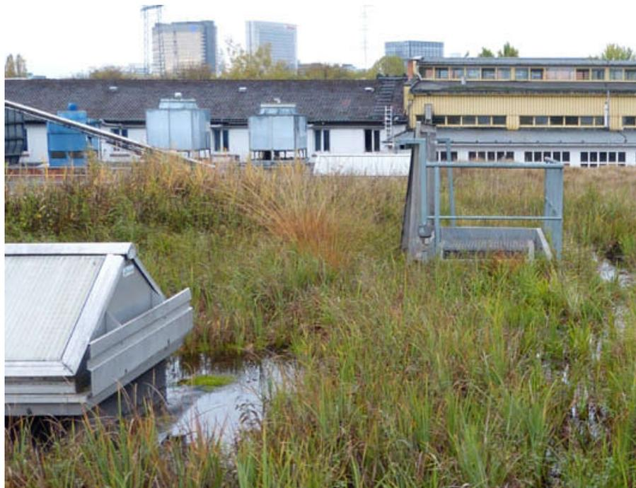
Abbildung 67 - Dachbauweise zur Regenwasserrückhaltung: Ermöglicht die Nutzung des Regenwassers und vermindert Abflussspitzen bei Starkregenereignissen (Quelle: Nicole Pfoser 2012)
