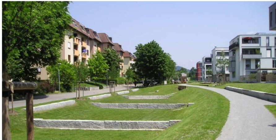
*Abbildung 49 - Dezentrales Regenwassermanagement sollte gestalterisch in den öffentlichen Raum integriert werden - dadurch können mehrfach nutzbare Freiräume entstehen (Quelle: AG Freiraum)*
