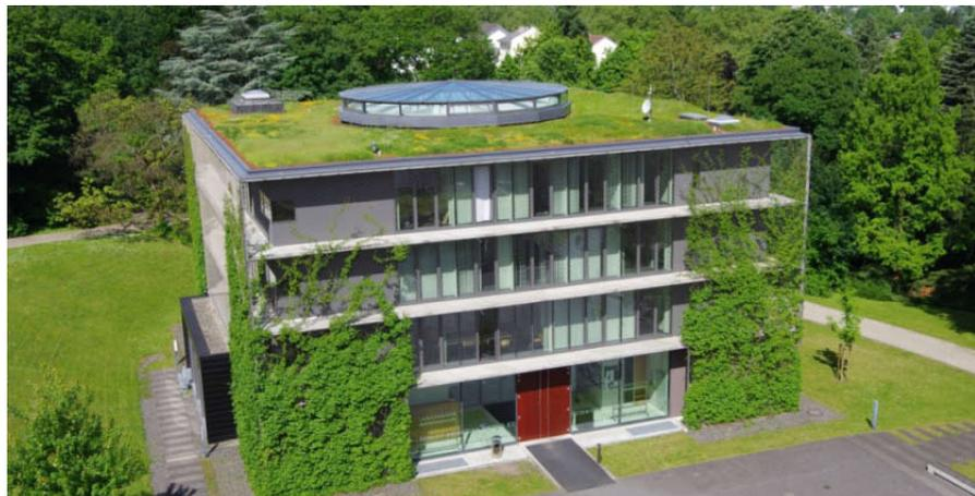
Abbildung 80 - Dach- und Fassadenbegrünung sollten in Ludwigsburg stärker beworben werden. Neben den positiven Effekten auf das Rauminnenklima wird auch eine positive Außenwirkung erzielt (PTH St. Georgen, Quelle: Nicole Pfoser 2013)
