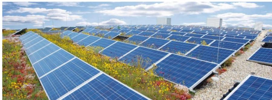
Abbildung 56 - Gute Synergie: Hochwertige extensive Dachbegrünung und Photovoltaik (Quelle: optigrün)
