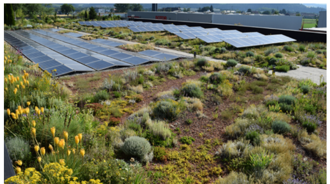
Abbildung 6: Konzept der räumlichen Trennung von Solar-Anlage und Gründach
