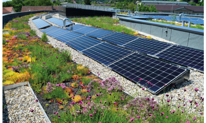
Abbildung 5: Konzept der räumlichen Trennung von Solar-Anlage und Gründach – hier auf dem kommunalen Gebäude
