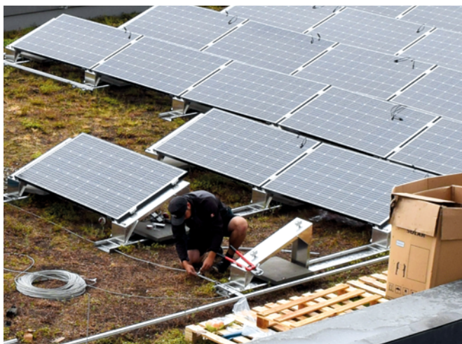
Abbildung 7: Montage einer PV-Anlage auf ein bestehendes Gründach.
