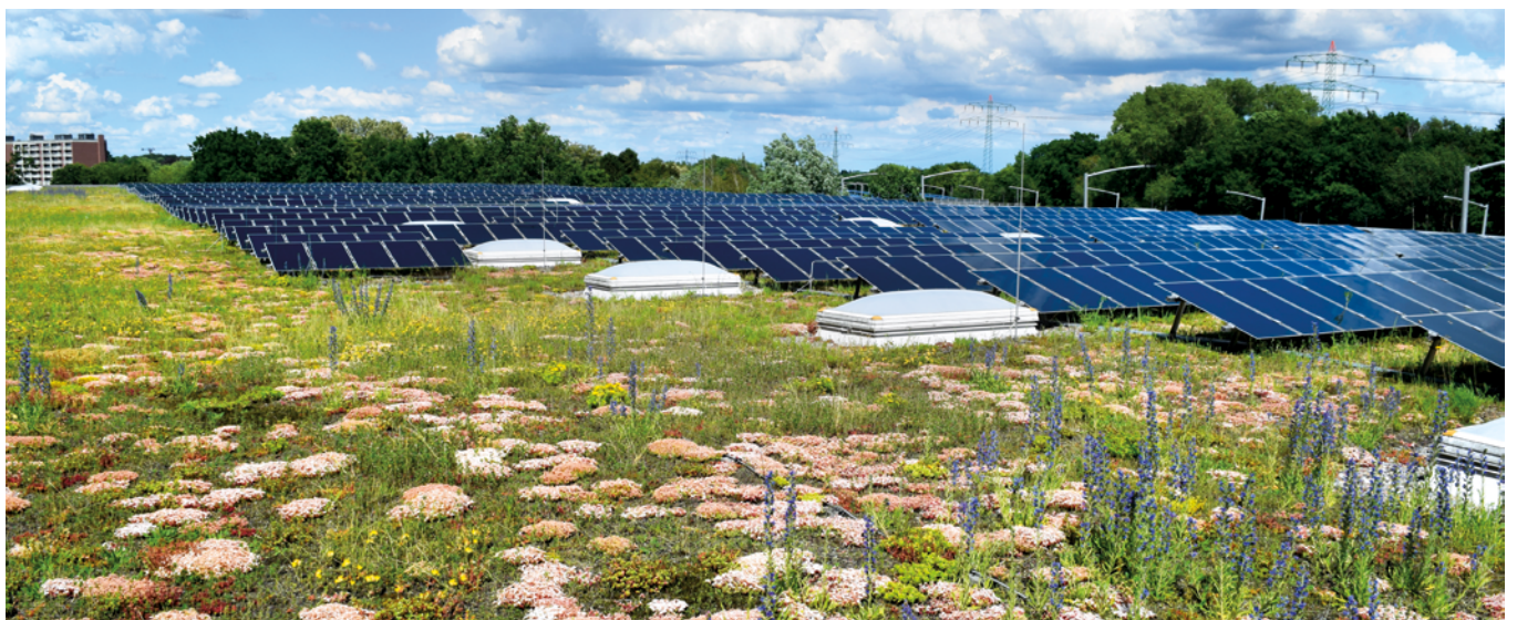
Abbildung 2: Praxisbeispiel eines Dachaufbaus
