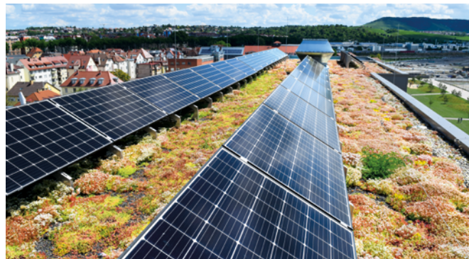
Abbildung 3: Photovoltaik und Gründach sind unmittelbar auf der selben Fläche verbunden. Hier sind die Module in eine Richtung ausgerichtet.
