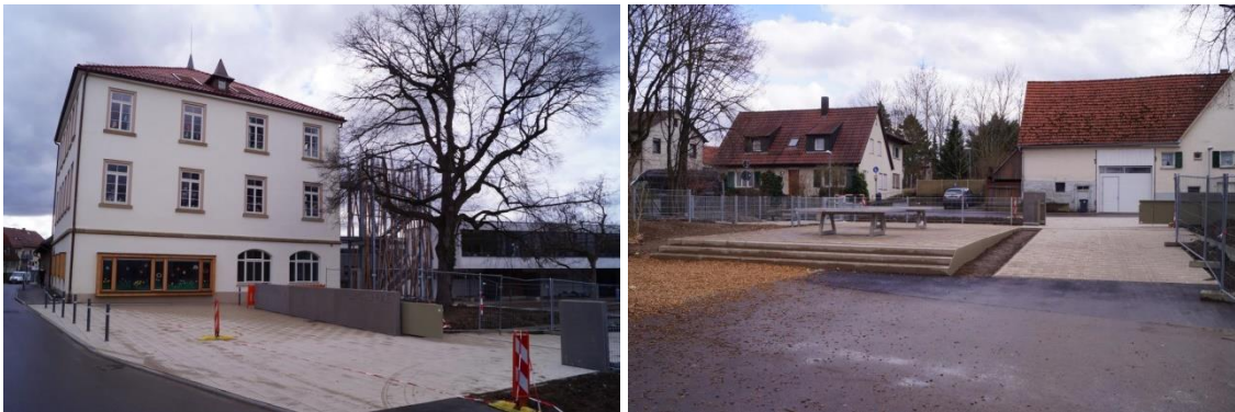
Impressionen vom fast fertigen 1. Bauabschnitt der Außenanlage Lembergschule
