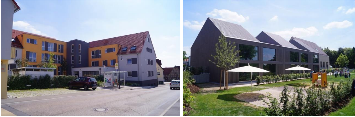
Umgesetzte Maßnahmen aus den Sanierungszielen
