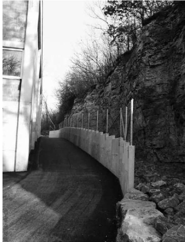
Am Osteingang zum Grünpark Hungerberg im ehemaligen Steinbruch Hubele musste der Fußweg durch eine massive Betonelementwand und durch Maschendrahtzaun gegen herabfallende Steine gesichert werden. Die stark geklüftete und aufgelockerte Felswand aus Karbonatgesteinen des Oberen Muschelkalks und an der Oberkante aus lockeren Schotterkonglomeraten des Pleistozäns (Eiszeitalter) wurde mit einem Bagger beräumt.
