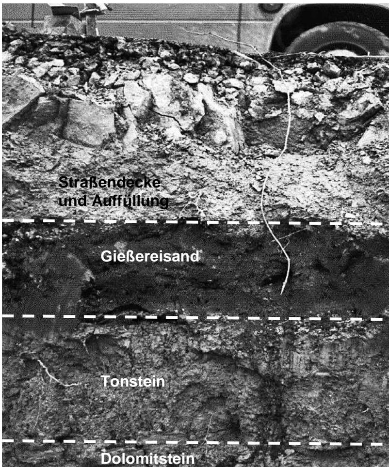
In der steil geböschten Baugrube (Sicherung?) liegen unter der Auffüllung verwitterte Tonmergelsteine und eine angewitterte Dolomitsteinbank des Lettenkeupers.
