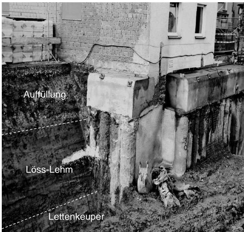
Bei diesem Bauvorhaben in der Alleenstraße wurde das Nachbargebäude durch eine überschnittene Bohrpfehlwand gesichert.
