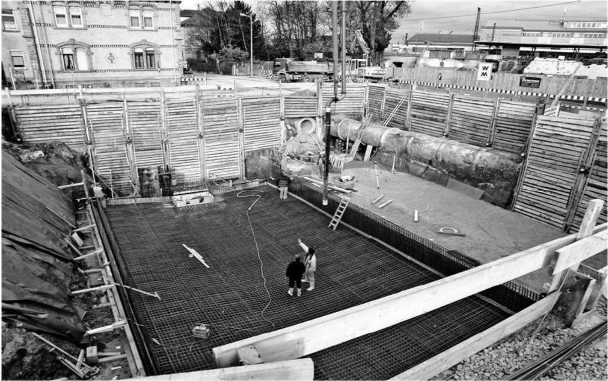
Zwei Baugruben mit rückverankertem Trägerbohlenverbau (vertikale Stahlträger und Holzbohlen als Ausfachung). Oben links ist die Grubenwand geböschet und mit Folie gegen Austrocknung abgedeckt.
