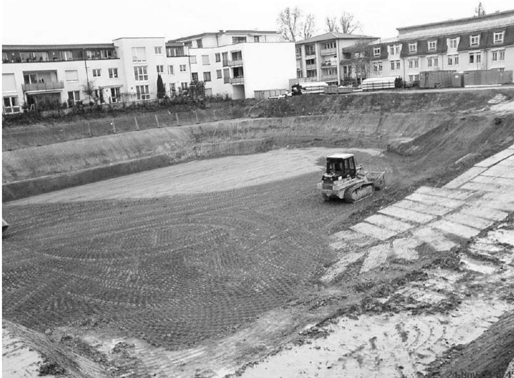
**Bildtafel 15: Abbruch- und Bodensanierung auf dem Gelände der ehemaligen Flakkaserne - Hartenecker Höhe (2010 - 2012)**
