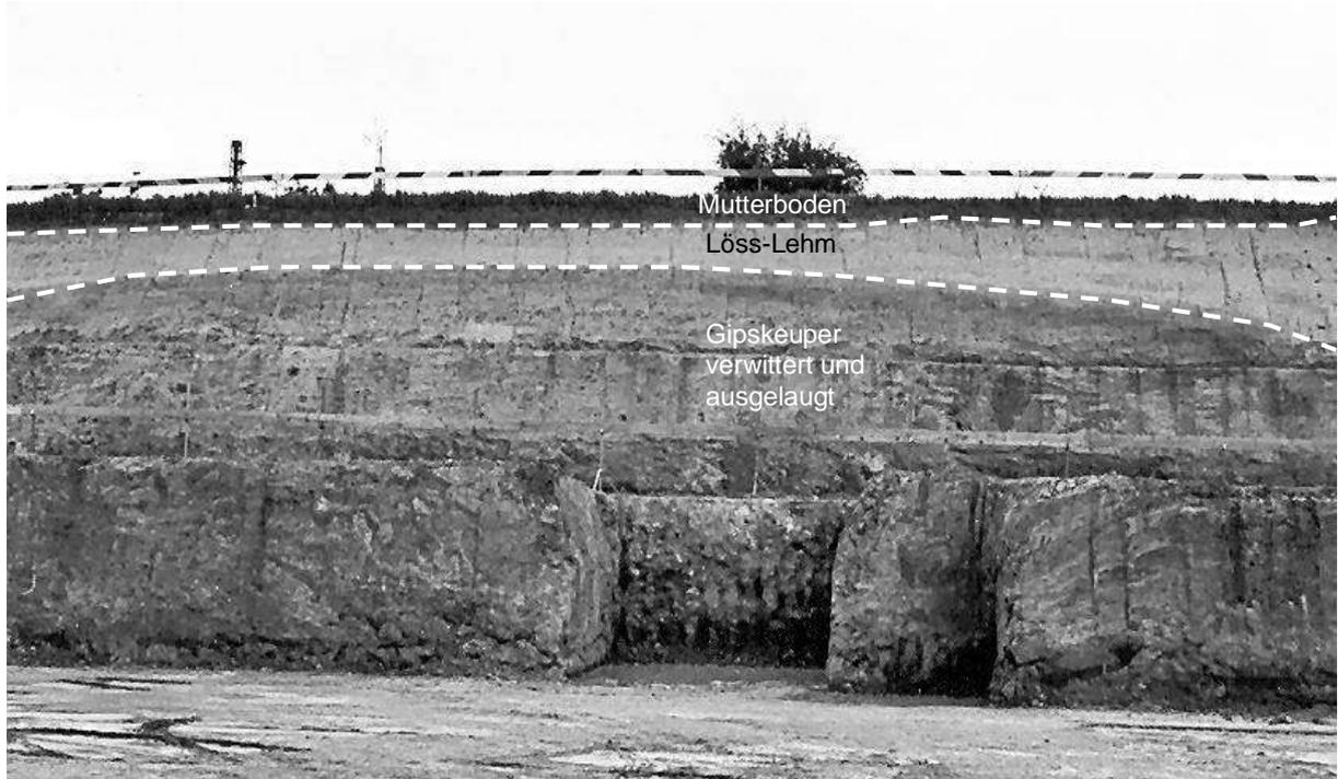
An der Baugrubenwand sieht man ca. 20 - 40 cm Mutterboden über 0,5 - 2 m Lösslehm und Löss. Darunter liegen verwitterte und angewitterte Gipskeuperschichten.
