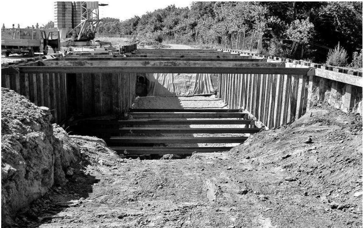
Beim Bau dieses Regenüberlaufbeckens wurde ein nach innen ausgesteifter Spundwandverbau mit Stahldielen verwendet.
