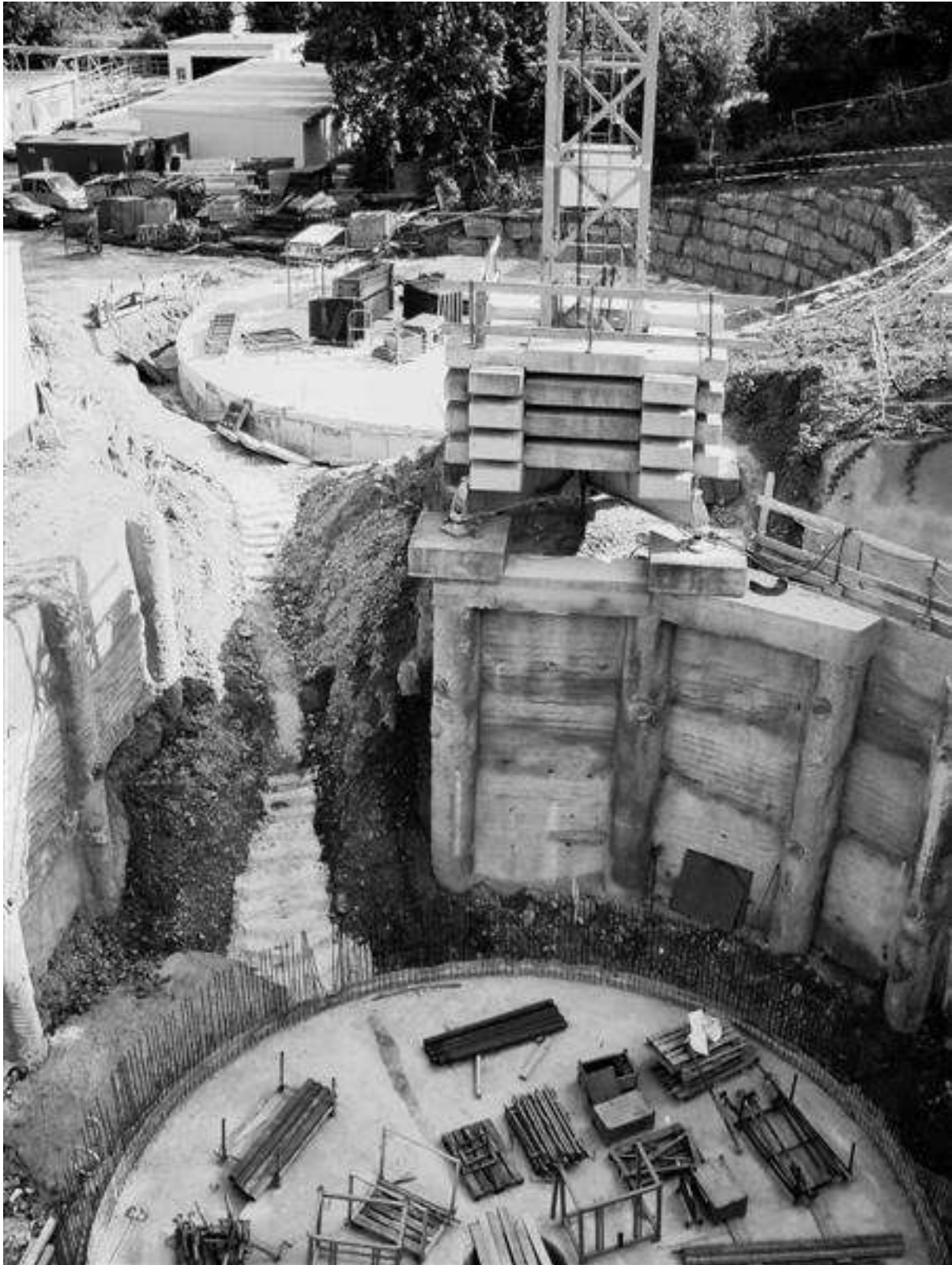
Die Baugruben der 2 Faultürme und die Bodenplatte des Gasbehälters im Überblick: Oben rechts neben dem Gasbehälter wird der Hang durch Blocksteine gesichert. Der Baustellenkran sitzt auf Bohrpfählen der Pfahlwand für die Baugrube der Gasbehälter. Diese ungewöhnliche Anordnung wurde statisch berechnet und als standsicher bewertet.
