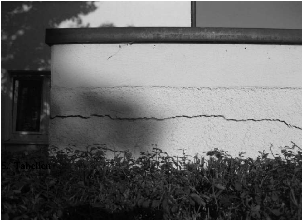
Abb. 20: Das Bild zeigt einen Garagenanbau an einem Haus in Ludwigsburg-Poppenweiler. Ursache für den großen Riss ist vermutlich der bindige Lehm Boden, der in trocknen Jahreszeiten tief ausgetrocknet und geschrumpft ist. Mit ursächlich könnten auch wasserbrauchende Bäume in der Nähe der Garagenwand sein. Die flach gegründete Garagenwand hat sich mit dem schrumpfenden Boden gesetzt. Solche Schäden sind im Ludwigsburger Raum und im Strohgau wegen der weitverbreiteten Lehm Böden nicht selten.
