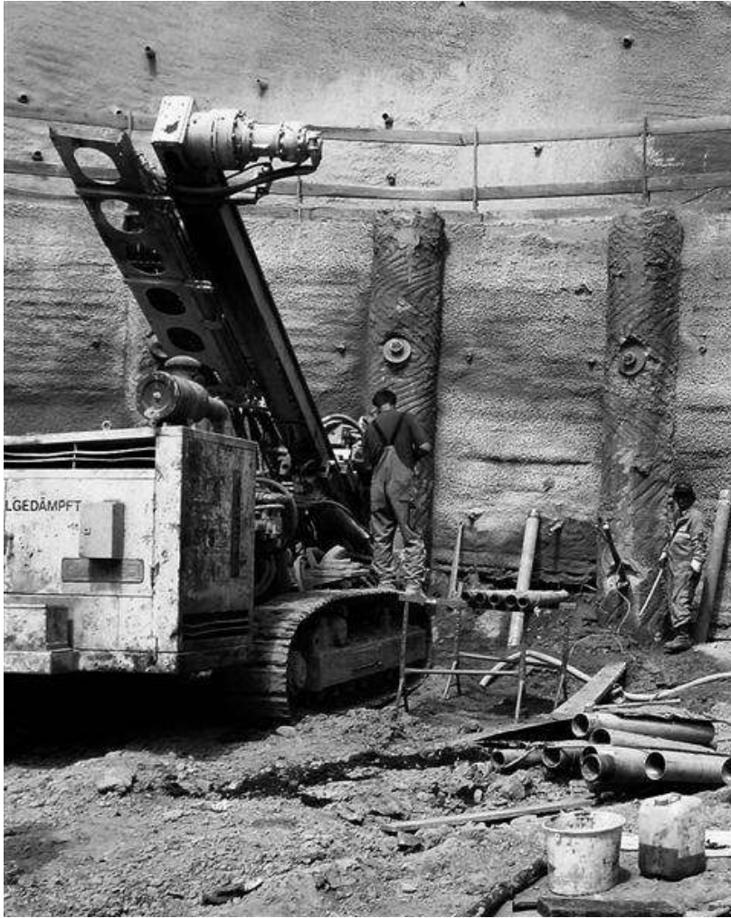
Die vor dem Aushub gebohrten und betonierten Pfähle werden im Zuge der schrittweisen Baugrubenvertiefung in 2 Reihen mit vorgespannten Ankern gesichert.
