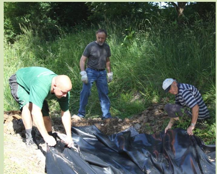
Anschließend wurde dieser Abschnitt, der ca. 35 qm groß ist, befestigt, unterfüttert und mit Teichfolie ausgelegt.
