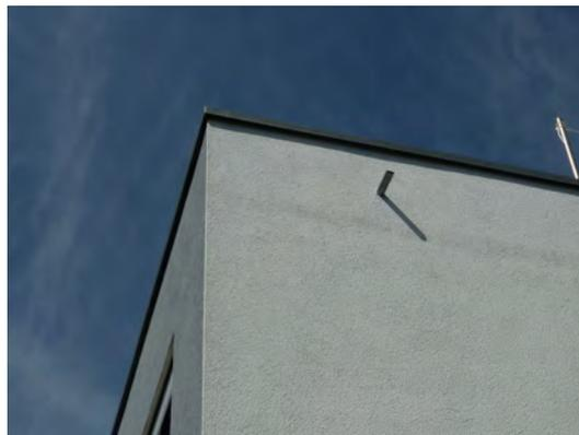
Abbildung 17: Flachdach mit geringem Dachüberstand
