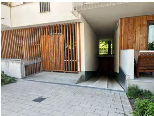
Abbildung 25: Beispiel Fahrradrampe ins Untergeschoss
