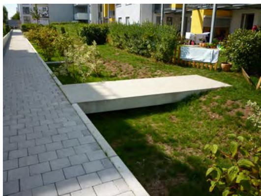
Abbildung 40: Beispiele Regenwasserversickerung
