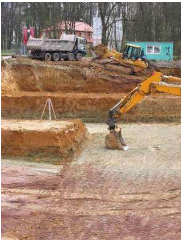
Bild 12 links: Lösslehm und Löss über freigelegter Baugrubensohle aus Gipskeuper (ausgelaugte Grundgipsschichten). Bild 13 rechts: Alter Hohlweg im über 10 m mächtigen Löss an der Lechtsteige in Ludwigsburg-Neckarweihingen.
