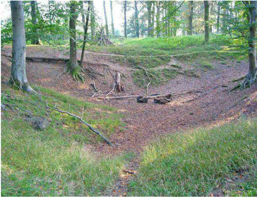
Bild 7: Erdfall im Favoritepark Ludwigsburg. Lösungsvorgänge in den Kalksteinen des Oberen Muschelkalks und in den Sulfatgesteinen des Mittleren Muschelkalks haben zum Durchbrechen der schlotartigen Aushöhlung durch die Schichten des Lettenkeupers bis an die Erdoberfläche geführt. Der Erdfall ist mit Versturzmassen plombiert und das Regenwasser versickert bis in den Muschelkalk. Die Erdfallbildung im Oberen Muschelkalk und im Lettenkeuper im Raum Ludwigsburg und im Strohgau hat ihren Ursprung in der abgeschlossenen Auflösung der Salzgesteine und in der teilweisen Auflösung der Sulfatgesteine im Mittleren Muschelkalk. Das hat zum Zerbrechen und zur Absenkung und des darüberliegenden Gesteinspakets des Oberen Muschelkalks um ca. 20 – 40 m geführt (Abb. 28). Auf der Ludwigsburger Gemarkung sind etwa 15 erdfallartige Karststrukturen und 3 Erdfälle bekannt. Die gesamte Markung Ludwigsburg ist verkarstungsgefährdet. Im Kartenviewer des LGRB-Freiburg gibt es eine "Ingenieurgeologische Gefahrenhinweiskarte" https://maps.lgrb-bw.de/
