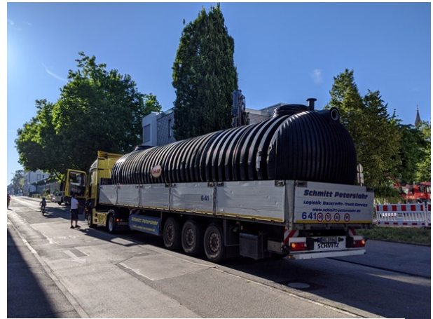
Anlieferung Zisterne Dragonergäble (Förderprojekt Straße der Zukunft)
