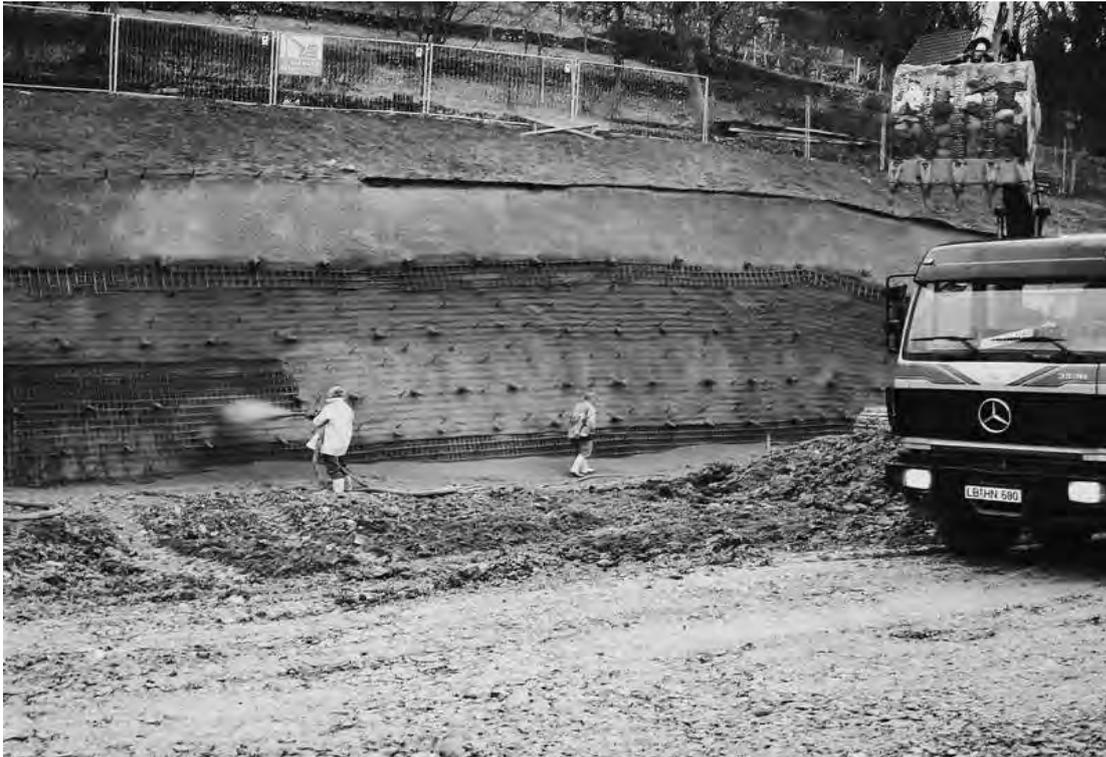
Der geböschte Bereich der Baugrube mit Hangschutt und Oberem Muschelkalk wurde mittels Bodenvernagelung und Spritzbeton auf Stahlmatten gesichert.
