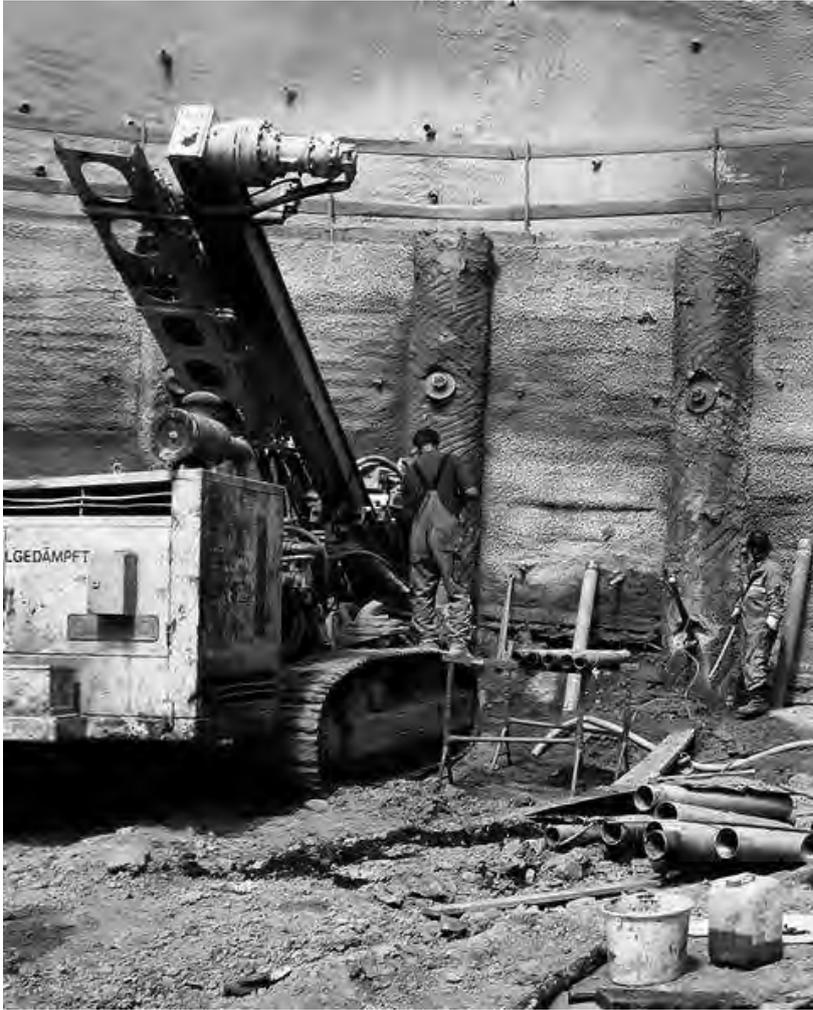
Die vor dem Aushub gebohrten und betonierten Pfähle werden im Zuge der schrittweisen Baugrubenvertiefung in 2 Reihen mit vorgespannten Ankern gesichert.
