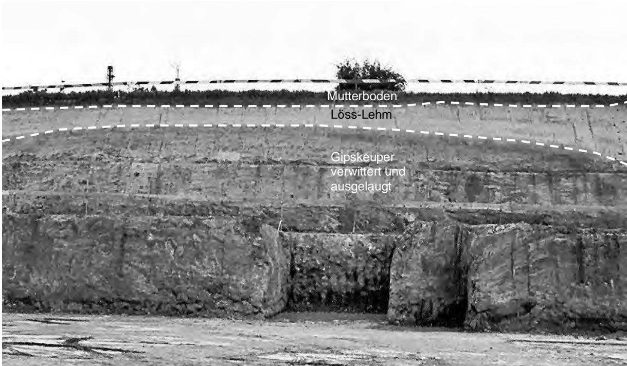
An der Baugrubenwand sieht man ca. 20 - 40 cm Mutterboden über 0,5 - 2 m und Lösslehm und Löss. Darunter liegen verwitterte und angewitterte Gipskeuperschichten.
