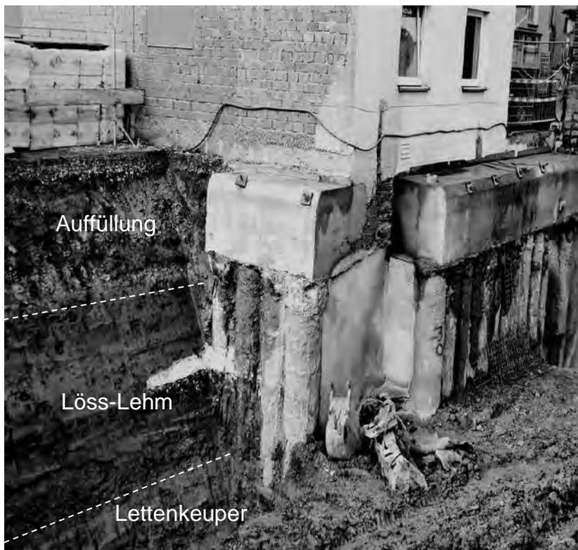
Bei diesem Bauvorhaben in der Alleenstraße wurde das Nachbargebäude durch eine überschnittene Bohrfahlfwand gesichert.
