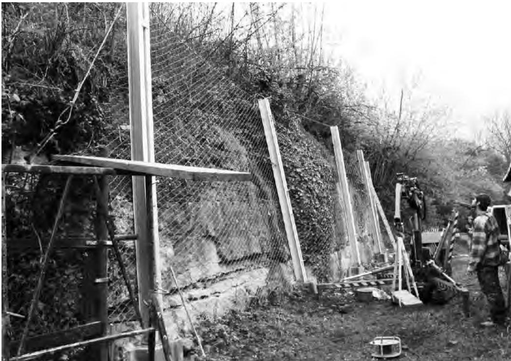
Im Bereich des Feldweges Sommerhalde kam es 2007 zu einem Steinschlag mit ca. 0,5 m<sup>3</sup> Volumen. Der Felshang, ein ehemaliger Steinbruch im Oberen Muschelkalk wurde mit verstärktem Maschendraht gesichert.
