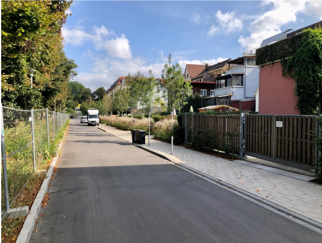
Sanierung Untere Kasernenstraße
