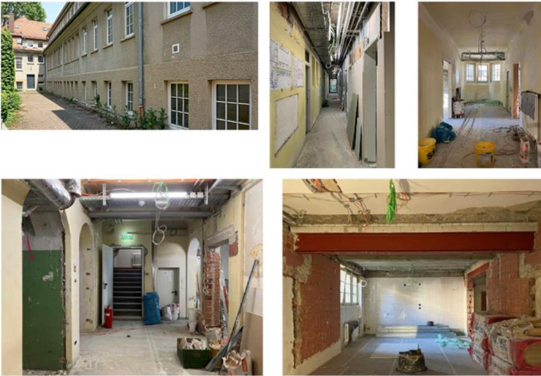
UG vor der Sanierung
