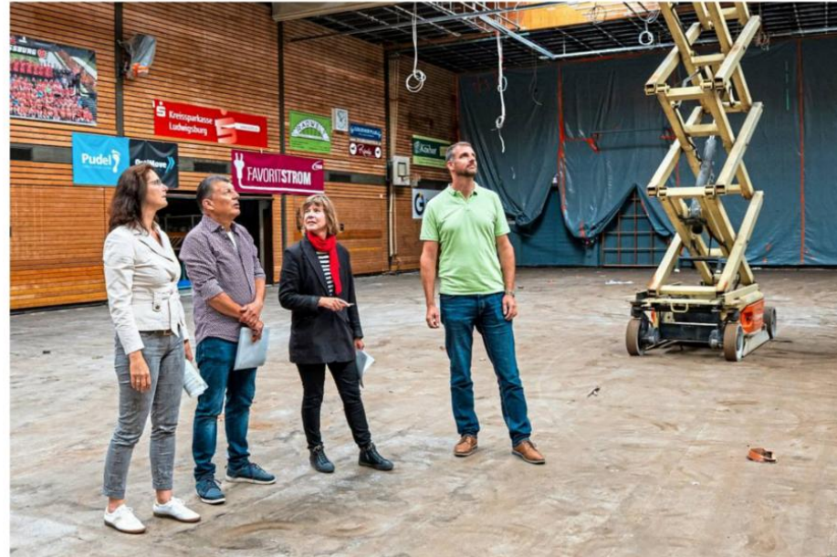
Blick nach oben: Die Sanierung des Hallendachs bildet den Schwerpunkt der Sanierung. Das Bild zeigt von links Baubürgermeisterin Andrea Schwarz, Markus Joas, Gabriele Barnert und Dominik Dinkel.
