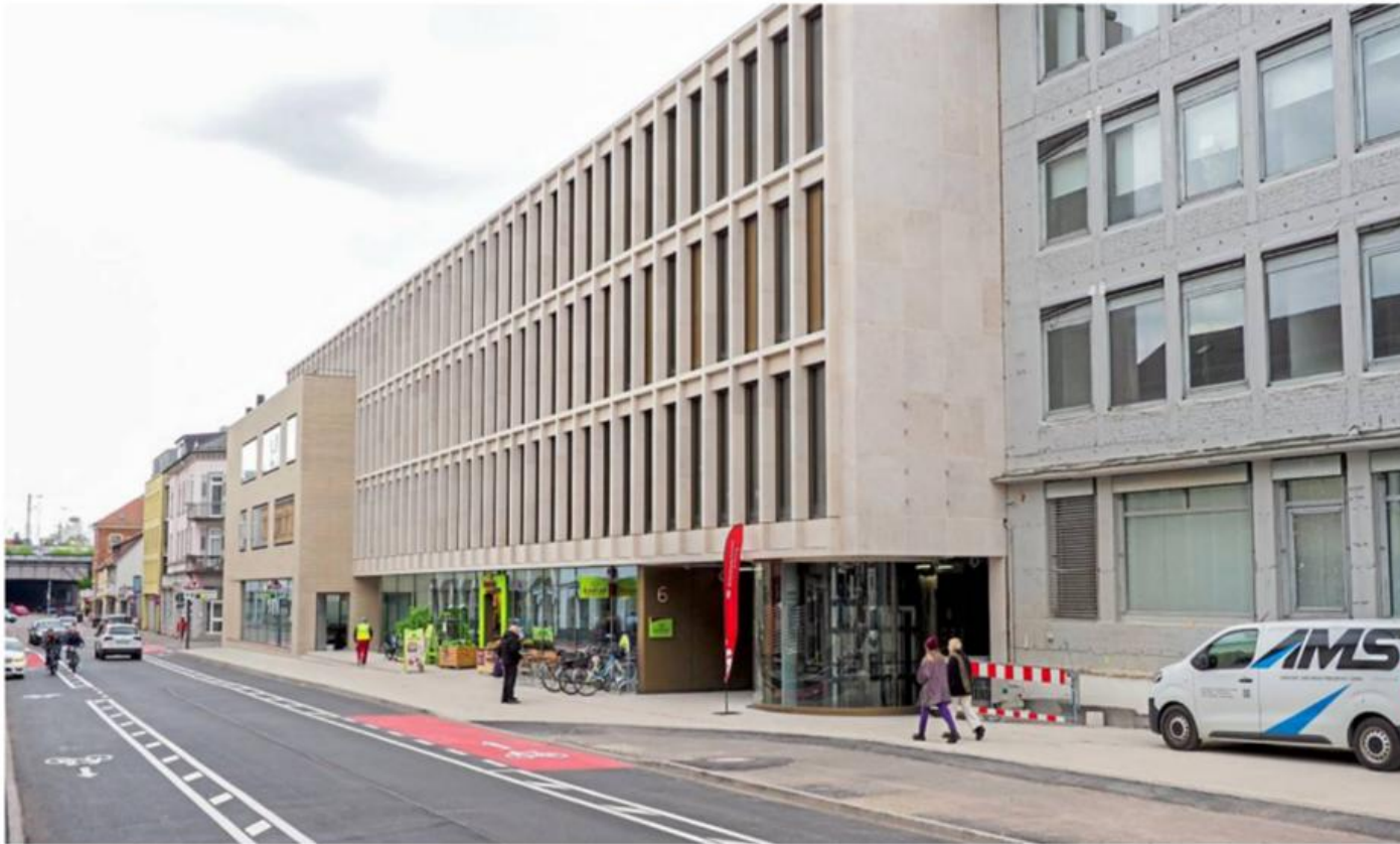
Die Schillerstraße mit einem der Neubauten. Direkt angrenzend (rechts im Bild) der Altbau, der jetzt saniert wird.
