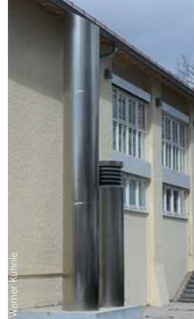
Die Wärmerückgewinnungsanlage entzieht der Abluft Wärmeenergie und heizt damit einströmende Frischluft wieder auf.
