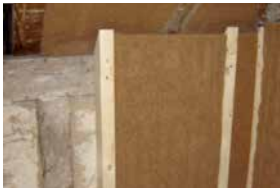
Innendämmung der Außenwand mit Holzfaserdämmplatten. Dampfdichtebene und Beplankung werden später eingebaut.
