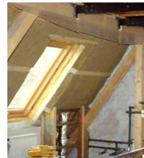
Innendämmung des Dachs. Dampfbremse und Gipsplatte werden anschließend eingebaut.
