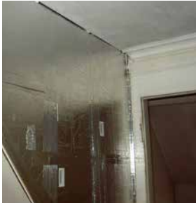
Platzsparende Dämmung einer Zwischenwand mit besonders dünnen, aber hocheffizienten Vakuumdämmplatten
