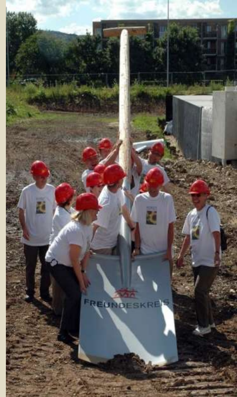
Spatenstich Baugemeinschaft „Horst“, Esslingen, Foto C. Weidenbach
