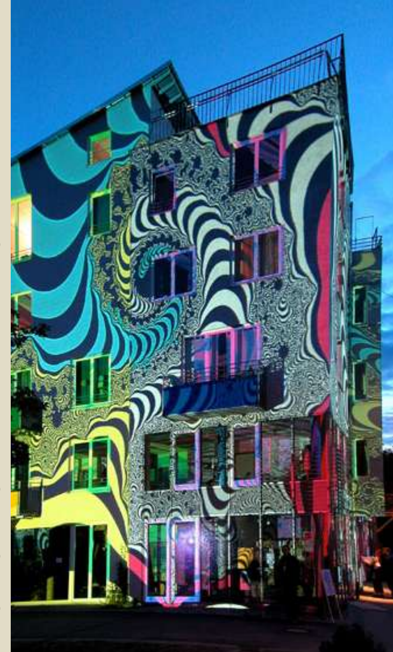
Fertigstellungsfest Baugemeinschaft „Werkstatthaus“, Tübingen, Fotos U. Schlierf
