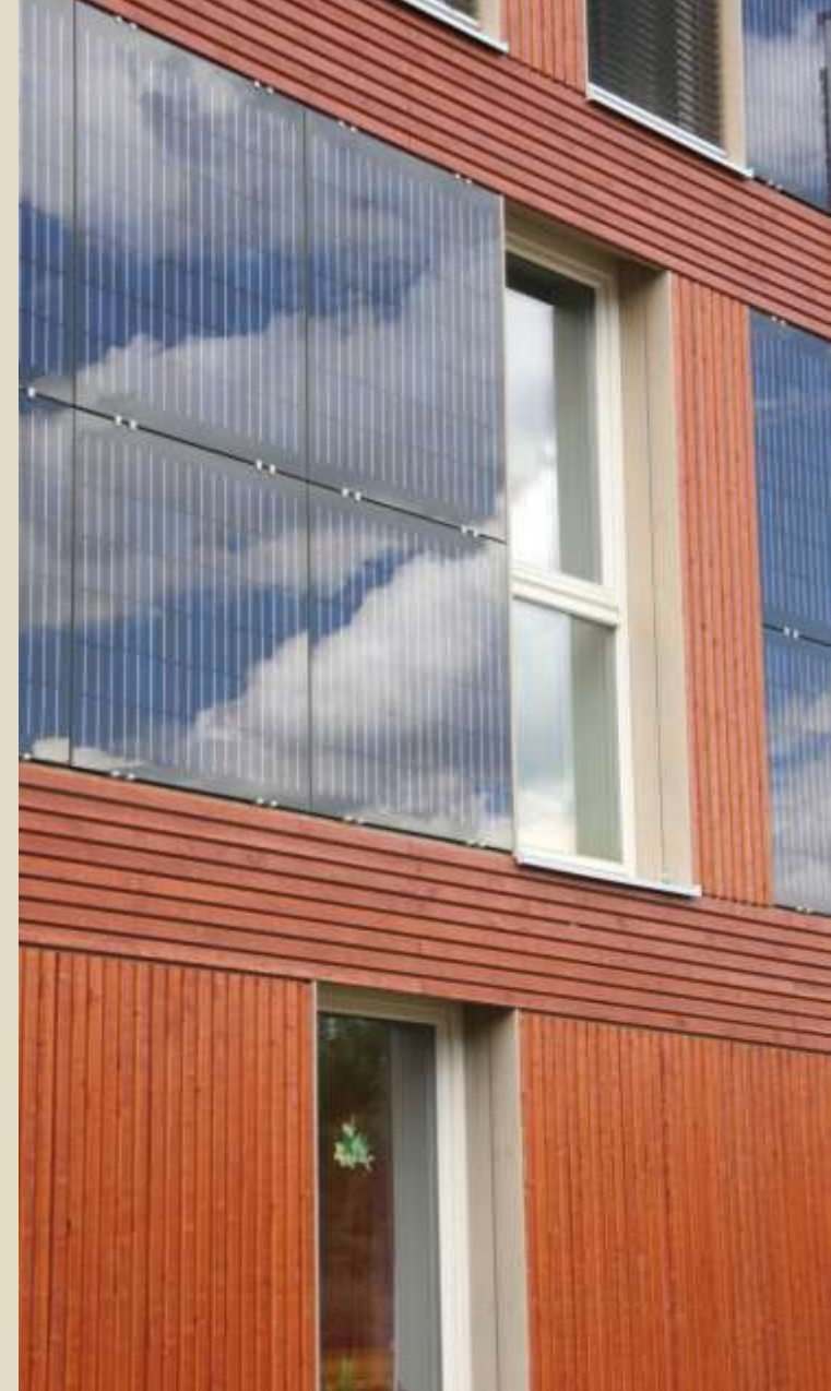
PV-Fassade Baugemeinschaft „elementar“, Tübingen, Foto T. Gauggel
