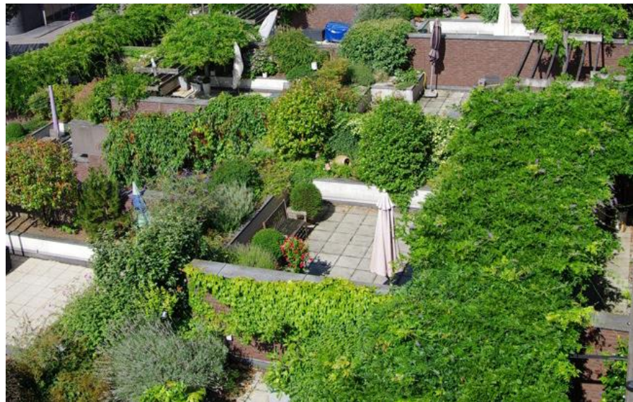
Abbildung 55 - Durch intensive Dachbegrünung können nutzbare Freiräume auf Dächern geschaffen werden (Quelle: Nicole Pfoser)
