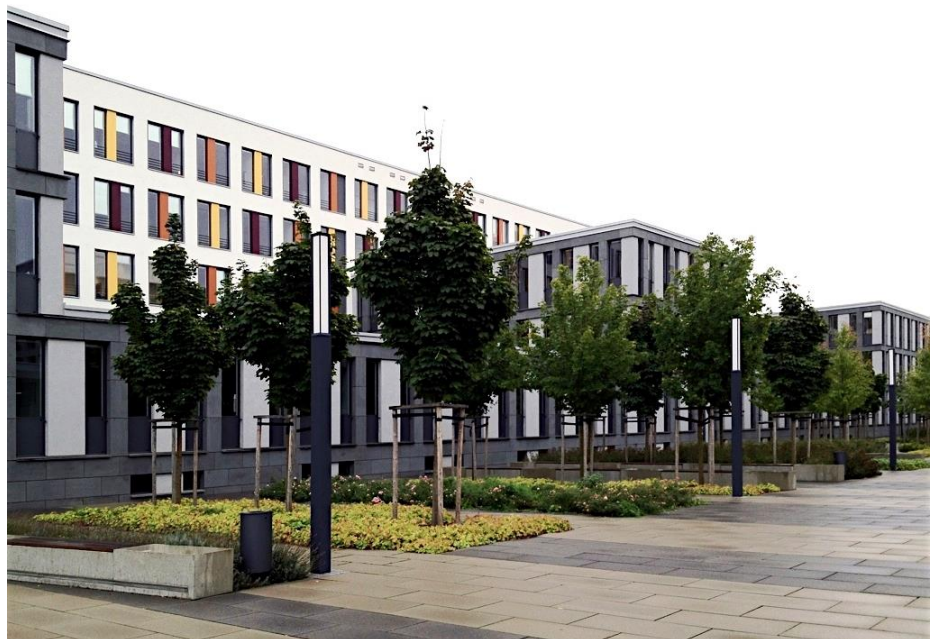
Abbildung 90 - Tiefgaragen sollten so gebaut werden, dass eine intensive Begrünung möglich ist. (Quelle: Nicole Pfoser 2012, Verwaltungszentrum Konradinerallee, Wiesbaden)
