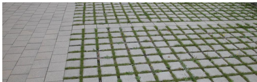
Abbildung 76 - Einfache Parkplatzentsiegelung mit Rasenpflaster. (Foto: faktorgruen)
