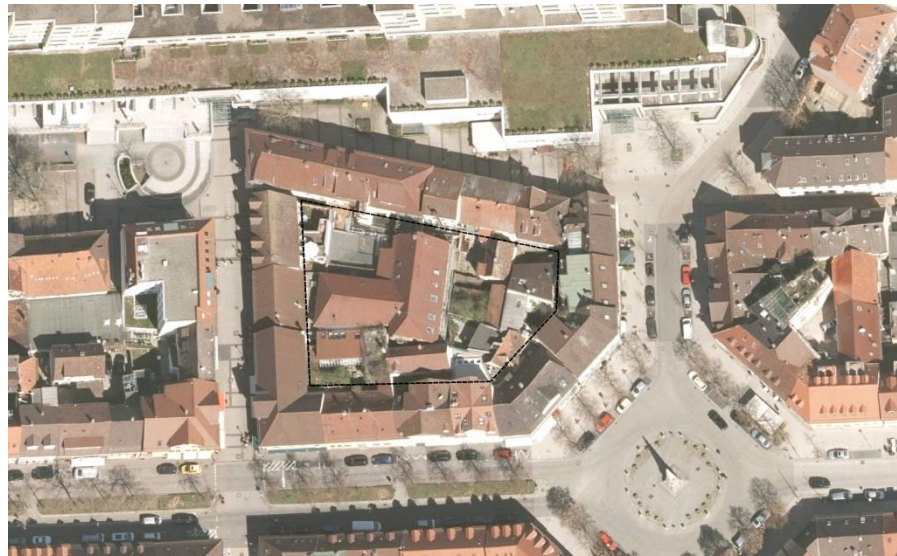
Abbildung 77 - Bei stark bebauten Innenhöfen sollten Potenziale für den Rückbau von nicht erhaltenswerter Gebäudesubstanz ermittelt werden (Quelle: Stadt Ludwigsburg)
