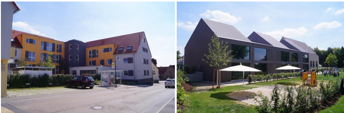
Umgesetzte Maßnahmen aus den Sanierungszielen
