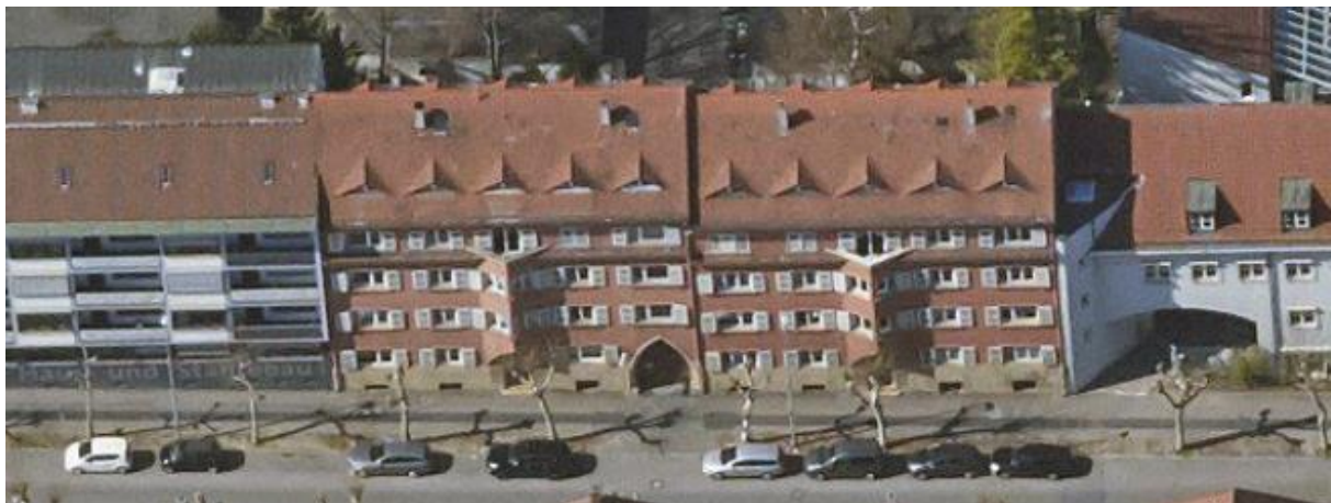
Gebäude Hohenzollernstraße 8-10, Luftbild: Stadt Ludwigsburg (2019)
