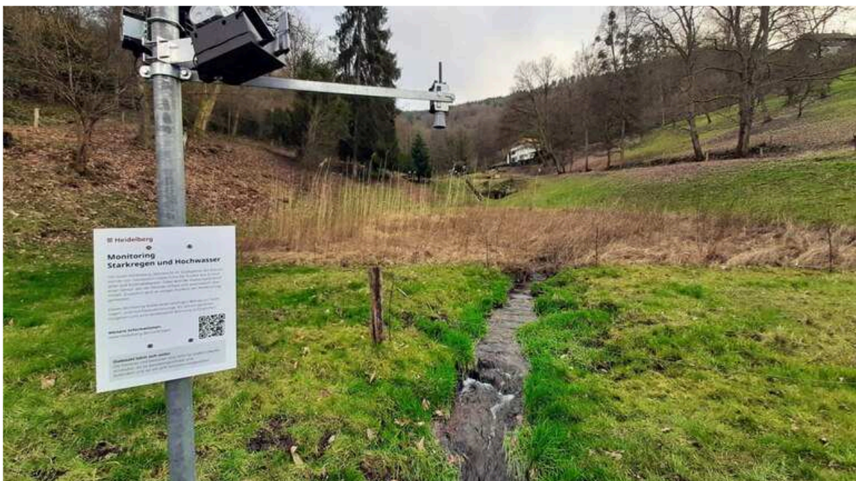
Abb. 6 Pegelmessstelle Nebengewässer Heidelberg (Bildquelle: /12/)
