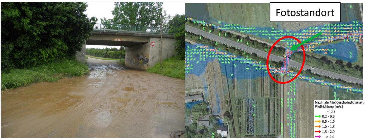
Abb. 11 Schlammablagerungen Straßenunterführung Ammertal/Münchinger Straße (Bildquelle: Gemeinde Möglingen)
