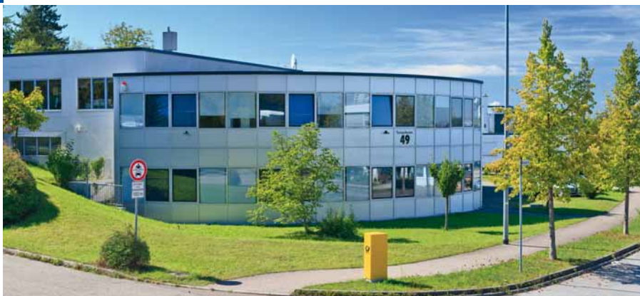
Das neue, größere Firmengebäude in der Teinacherstraße 49.
