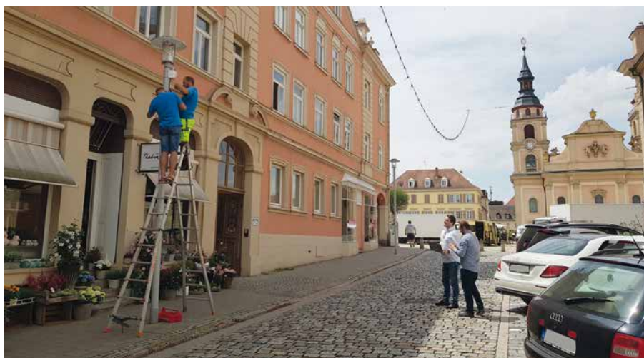
Installation des ParkingSpotters durch Mitarbeiter der SWLB.
