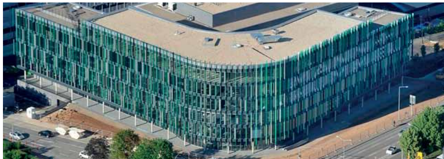
Von oben betrachtet: Das neue Technologiezentrum von MANN+HUMMEL.
