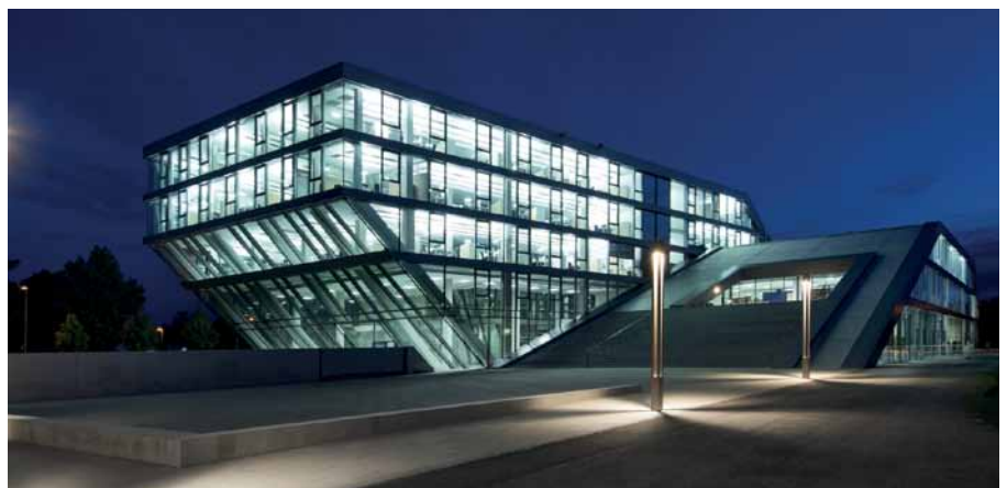
Weithin sichtbar: Die beeindruckenden Glasfassaden der neuen HAHN+KOLB-Zentrale bei Nacht.
