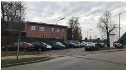
Vorher: Parkplatz Ecke Groenerstraße/Schlieffenstraße.
